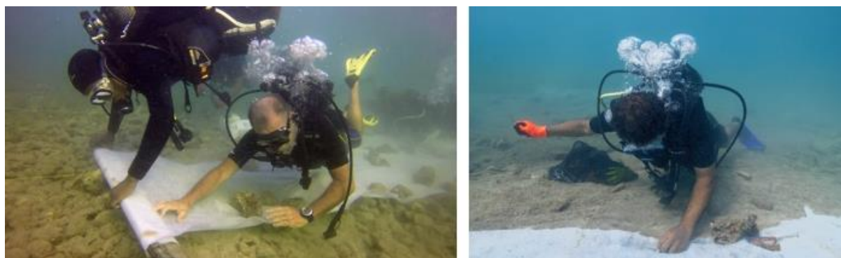
Figure 39. Unrolling the geotextile on Nossa Senhora da Consolação (IDM-003). Photo: Hilard Dean, 2017
